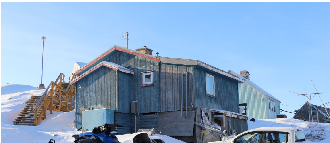
Illut aserfallassimasut isaterneqariaannaat | Faldefærdige huse til nedrivning
