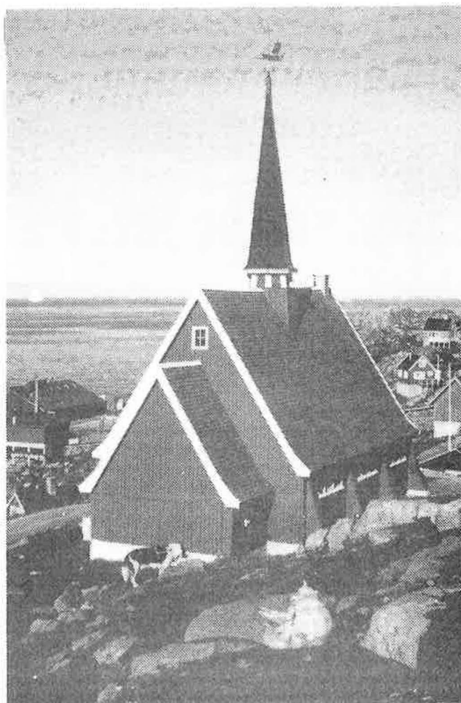
Bygningernes hovedform og detaljer vidner om arkitektens kunnen.
