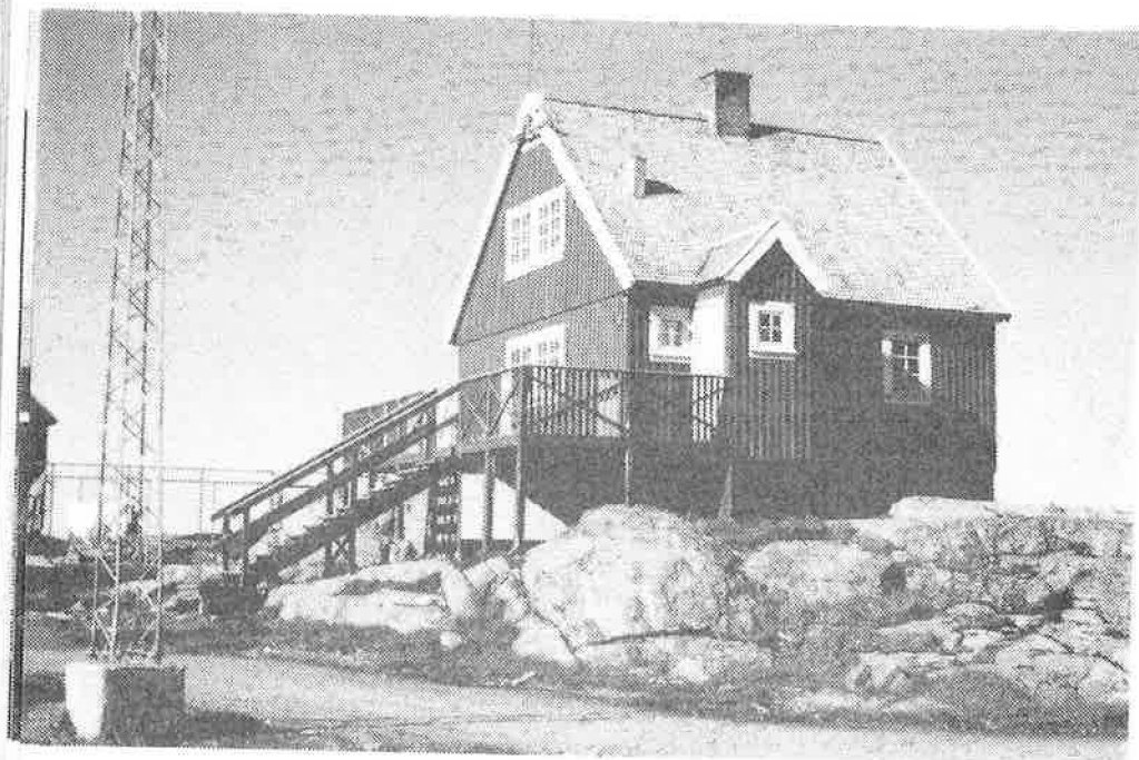
Fartøjsførerboligen B-17 har fået flere pæne tilbygninger.
