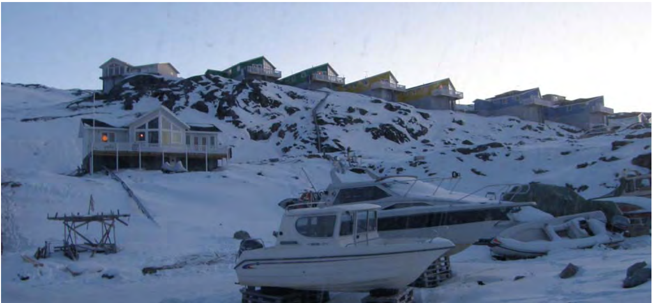
Sanaartorfissat nr. 1 aamma 2 suli atugassiarineqanngitsunut Qoororsuup Aqqusernanit isikkivik Udsigt fra Qoororsuup Aqquserna mod ledige byggelter nr. 1 og 2
